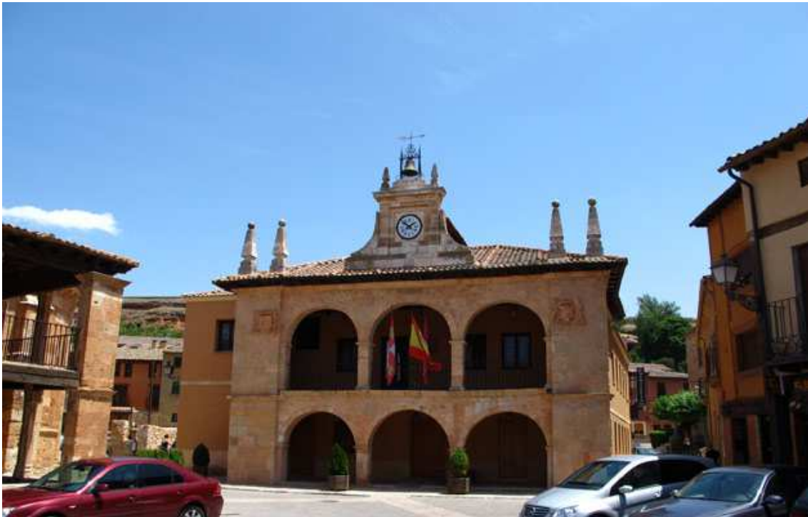
El Ayuntamiento de Ayllón al parecer fue el primer Palacio de los Marqueses de Villena. Construido en el siglo XVI y reformado en profundidad en 1804, fue arrasado por un incendio, en 1945, del que sólo se salvó la fachada.
