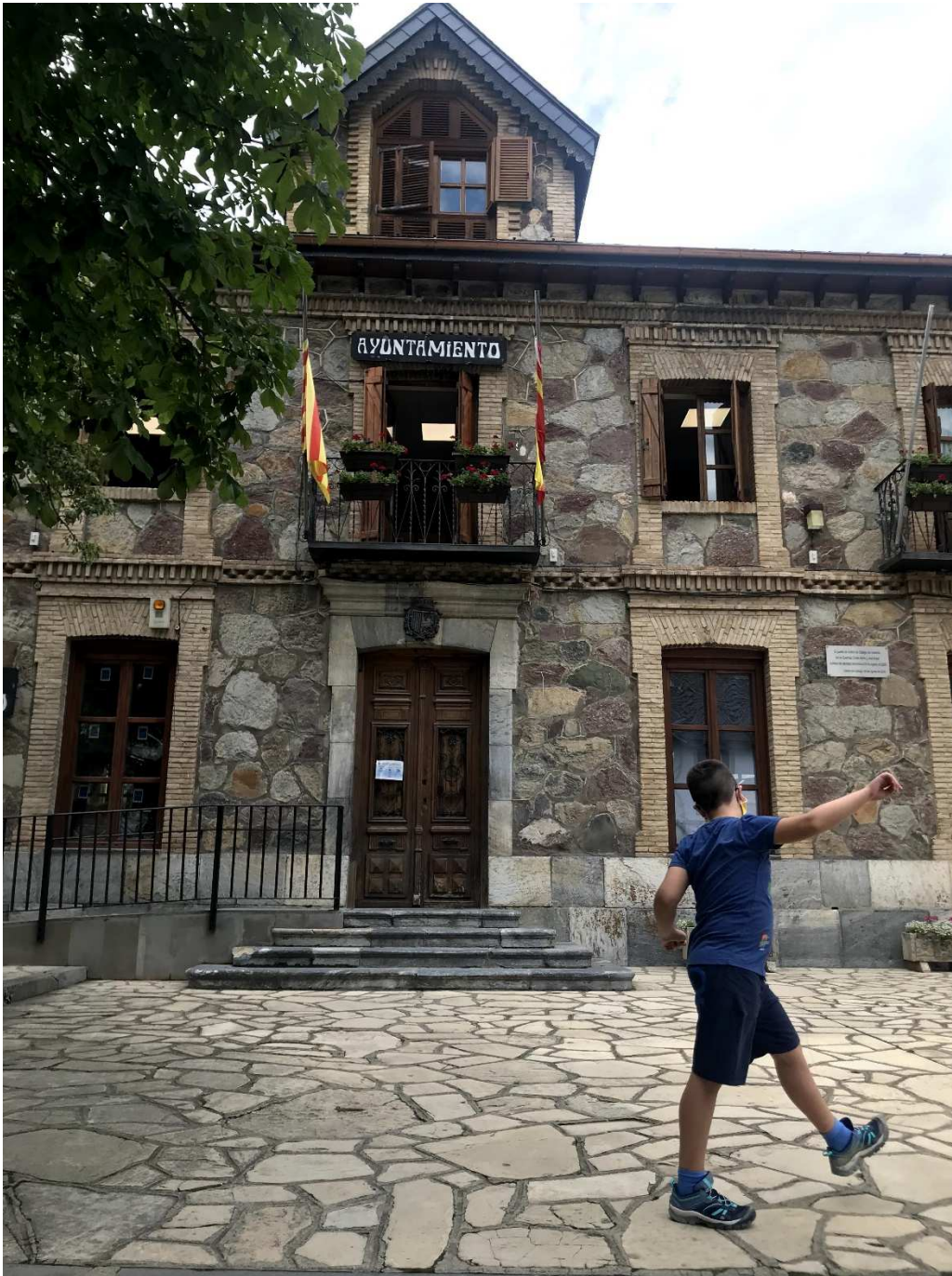
El edificio del Ayuntamiento con la estatua de Fermín Arrudi, más conocido como el gigante de Sallent. Una persona que llegó a medir 2,29m, a finales del siglo XX
