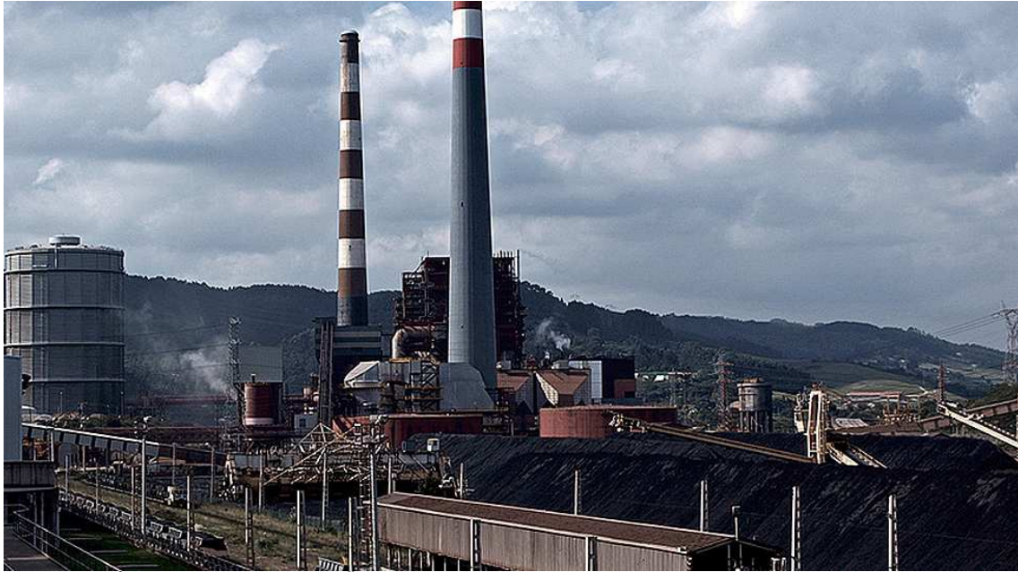
CENTRAL TÉRMICA DE HC EN ABONO
