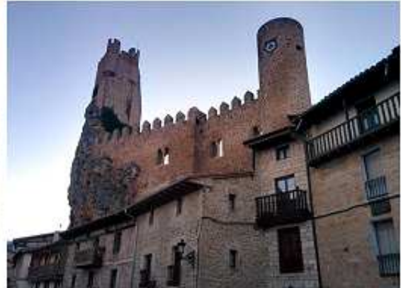
Vista del castillo desde el entramado urbano
