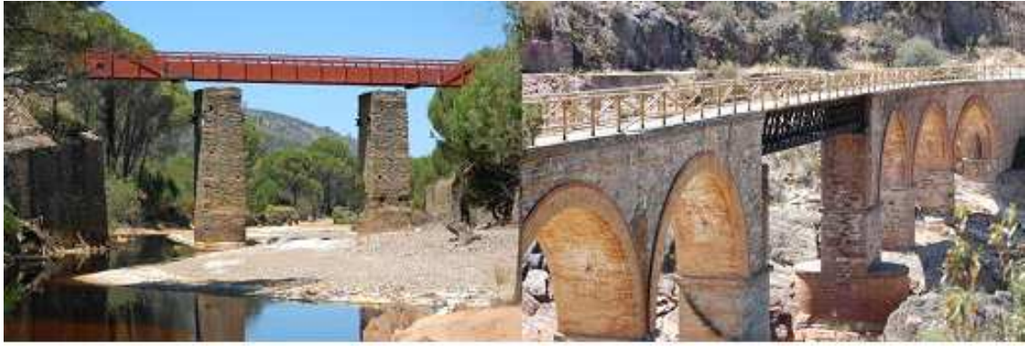
Puente colgante sobre el Tintillo.
